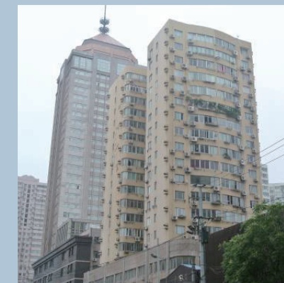
12号线嘉善路站相邻建筑海珠公寓 （民用建筑） 房屋现状检测
