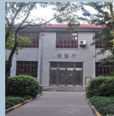
七宝二中叔逵楼（优秀历史保护建筑） 房屋质量综合检测
