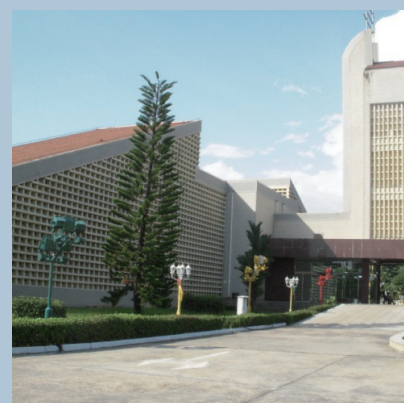
几内亚共和国总统府(官邸与接待用房) （民用建筑） 房屋质量检测
