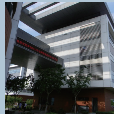
中国大地财产保险股份有限公司卡园三路 59号五号楼（民用建筑） 振动测试
