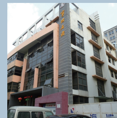
上海体育学院第二食堂五层（民用建筑） 屋面承载力评估
