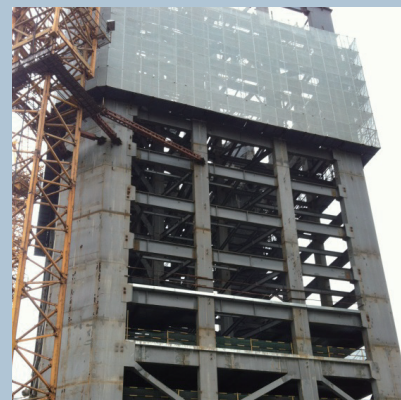
慈溪香格国际广场二期（民用建筑） 钢结构安全性检测鉴定
