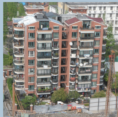
淮海名邸项目一期（民用建筑） 周边房屋损坏趋势检测
