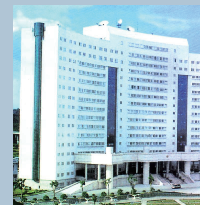
江阴市人民政府（民用建筑） 屋面、墙体裂渗检测
