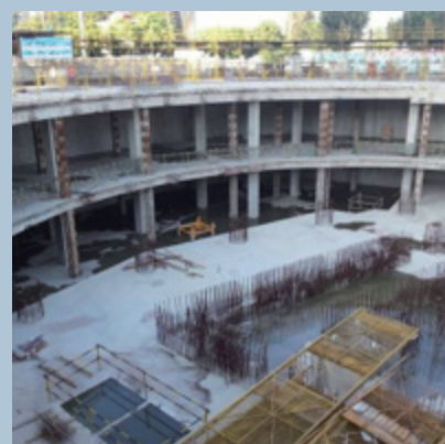
万科铜山街项目（翡翠滨江）地库（民用建筑） 工程质量检测
