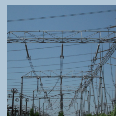
500 千伏繁昌变电站（构筑物） 钢管架构检测
