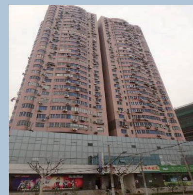
申汉小区（民用建筑） 房屋倾斜、沉降监测
