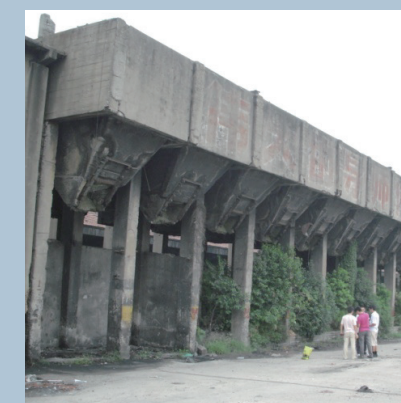
徐汇滨江保留建筑（构筑物） 北票码头煤炭装卸传送带检测
