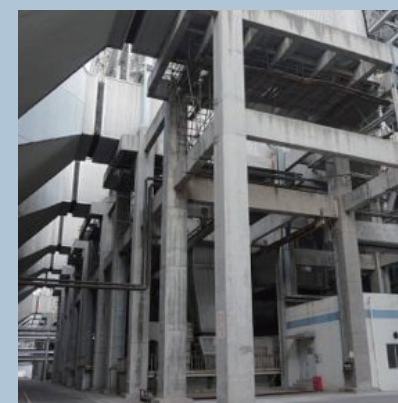
华能玉环电厂#2送风机（构筑物） 支架结构检测
