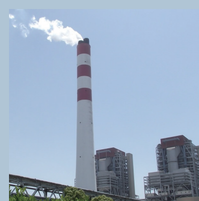
外高桥第三发电有限责任公司#7、#8机 总排放口（构筑物） 230m烟囱技术改造评估
