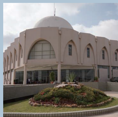
非洲毛里塔尼亚国际会议中心及总统府 （民用建筑） 安全检测
