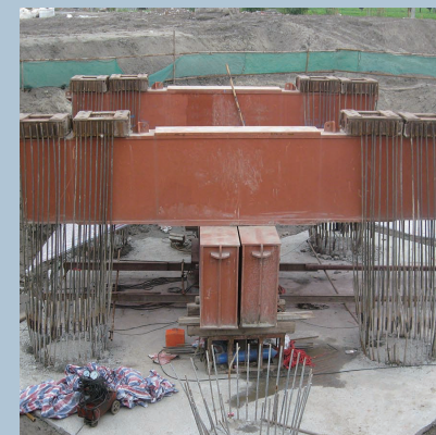
锚桩法承载力测试（地基与基础）
