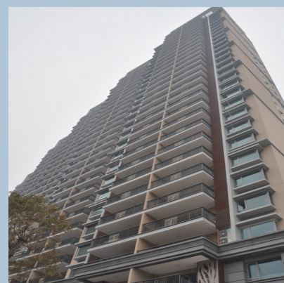
南京连城（民用建筑） 高层住宅装修质量检测
