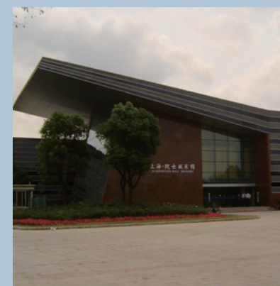
上海院士风采馆（民用建筑） 改建抗震鉴定
