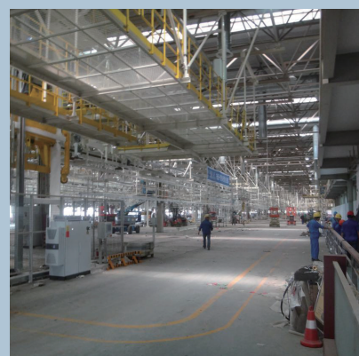
某新能源车厂房（工业建筑） 改建网架检测
