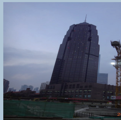
浦东金融中心基坑施工周边（民用建筑） 超高层建筑检测、监测
