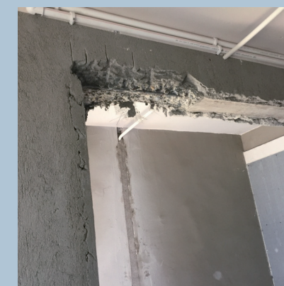
某高层住户（民用建筑） 拆除墙体恢复情况专项检测
