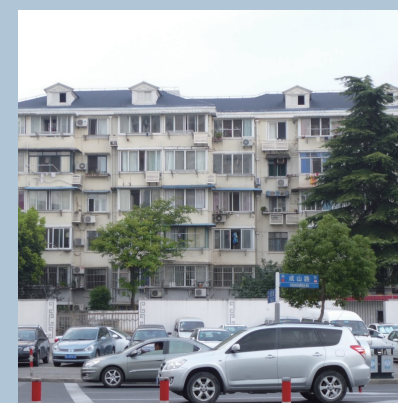
龙耀路隧道二阶段（民用建筑） 周边建筑物施工前完损检测
