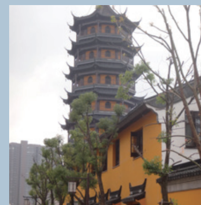
泰州文峰塔地宫（民用建筑） 拔柱托梁施工监测
